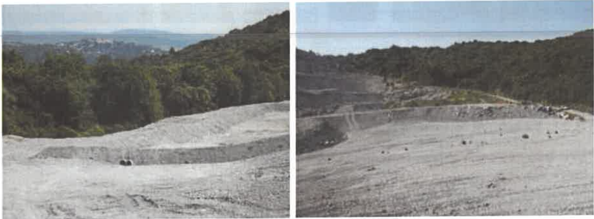
Figure 4 : Photographies après les travaux hydrauliques (2009)
